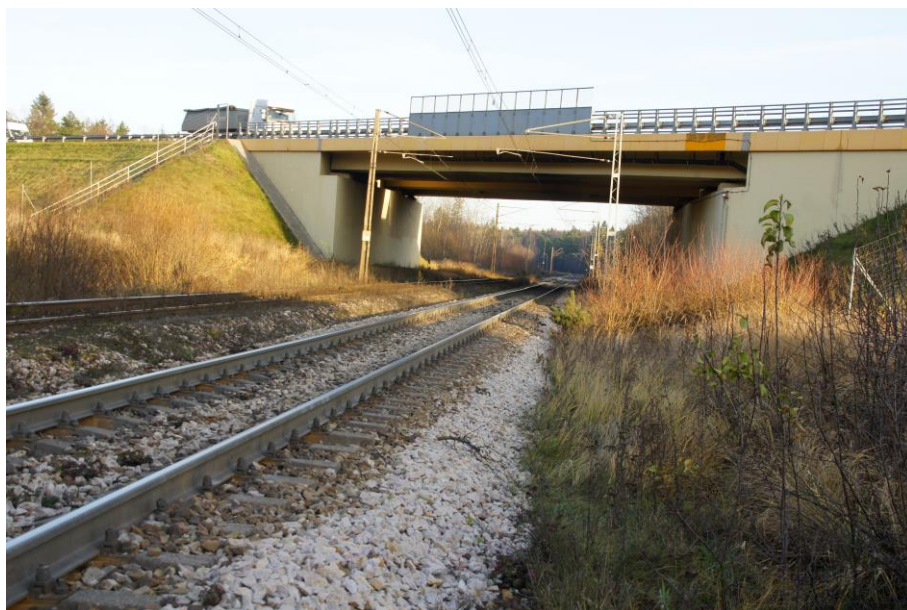
Fot. 6. Wiadukt drogi S7 nad torami kolejowymi w okolicach Zagnańska. Potencjalne przejście dla zwierząt łączące Puszcze Świętokrzyską i pasmo Klonowskie Gór Świętokrzyskich.
